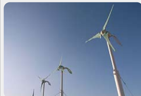
エアドルフィンを4機使用した定格 4.4kWのプラネットファームシステム
